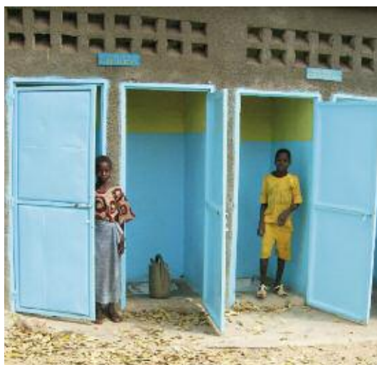
Latrines scolaires à deptkedougou - Sénégal
